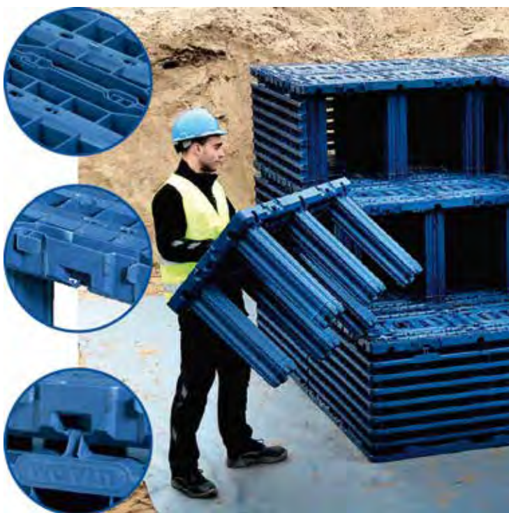
Rys. 13. Montaż systemu Wavin Q-Bic Plus.
