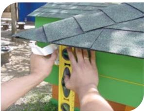
Presente un soporte en el muro en un extremo de la cubierta y otro en el punto donde se designará la bajante del canal, dejando una marca en la parte inferior de cada uno.
