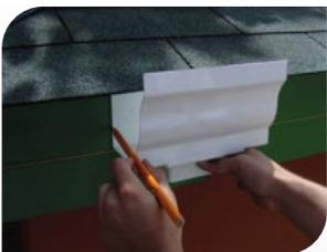
Alinee la "unión de canal a bajante" con el trazo del hilo y marque los agujeros sobre el muro. Ahora taladre en las marcas y posteriormente atornille la unión al muro.
