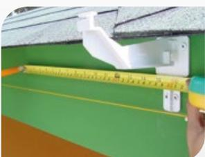
Alinee y coloque los soportes para canal distribuyéndolos de forma equidistante entre el extremo de la pared que es el punto de inicio y la "unión de canal a bajante", tomando en consideración un espaciamiento máximo recomendado entre soportes de 40 cm, proceda a marcar los agujeros de los soportes, taladre y coloque los soportes y atornille a la pared.
