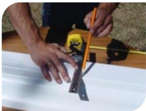
Marque a escuadra los tramos medidos anteriormente colocando un soporte al canal, proceda a cortar y retirar las rebabas.
