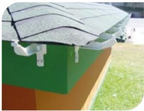
En el caso que se requiera esquineros, se deben colocar los soportes por ambos lados lo más cerca posible a dicha unión con el esquinero, ya que esta conexión no se atornilla al muro.
