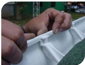
Proceda a ensamblar el canal en un accesorio, verificando que el canal llegue solamente hasta la señal indicada en la parte interna del mismo, e insertando el borde del canal en la parte interna del accesorio, gire el canal hacia abajo para un mejor apoyo y presione con los dedos el accesorio para ajustarlo al canal.
