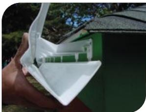
Lubrique todos los empaques de las conexiones de los canales lluvia, para facilitar el ensamble, así como la dilatación y contracción de los accesorios.
