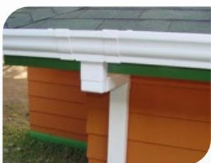
Verifique que la bajante quede a plomo usando el nivel de gota, y marque los puntos donde se van a colocar los soportes de manera equidistante a máximo 1.5 metros de separación. Taladre las marcas donde quedaran los soportes, coloque taquetes y atornille los soportes.
