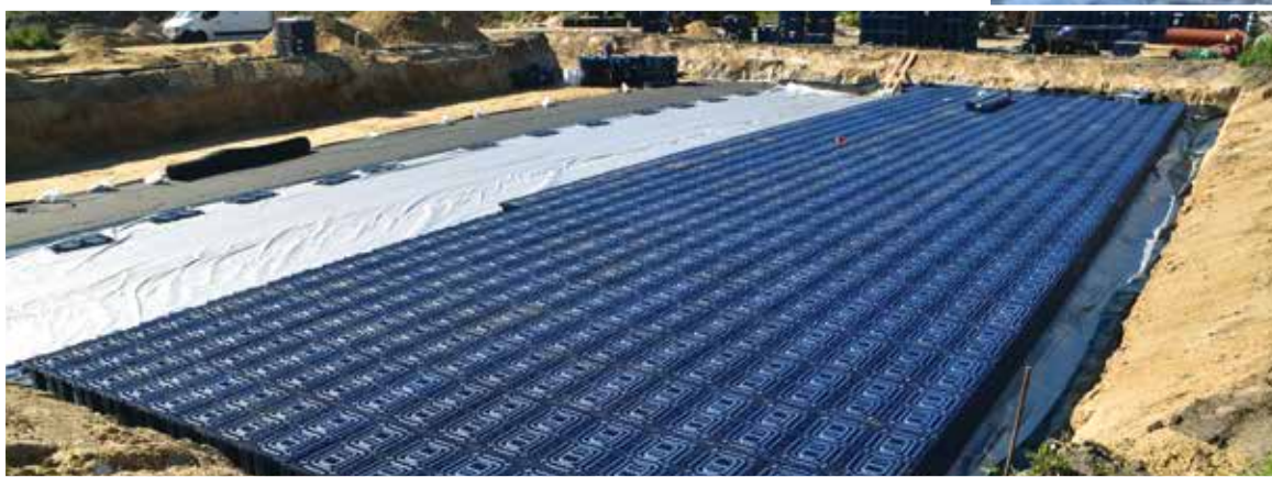
Hjertet i systemet: Q-Bic Plus filtrerings- og forsinkelsesreservoir til regnvandssystemer. Foto: Wavin
