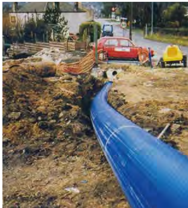
9. ábra: Csőbehúzás (Sliplining)
