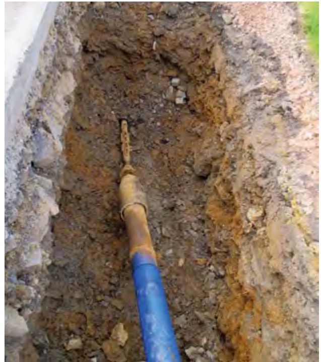
5. ábra: Vízszintes irányított fúrás (HDD)
