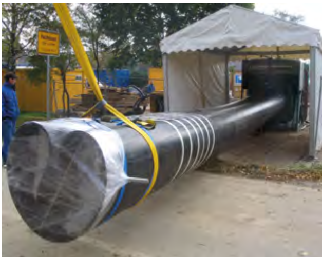
11. ábra: Helyszínen szűkített szorosan illeszkedő bélés (Subline)
