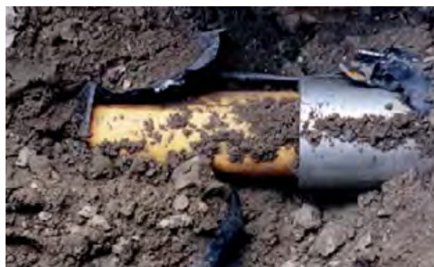
7. ábra: Csőroppantás
