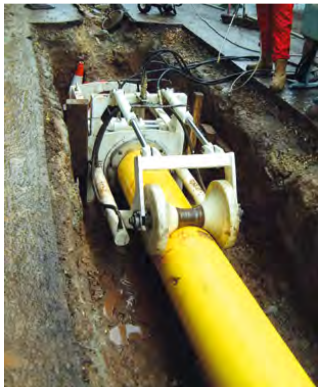
10. ábra: Helyszínen szűkített szorosan illeszkedő bélelés (Swagelining)
