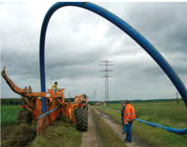
2. ábra: Irányított fúrás, beszántásos keskeny árokásás és csőroppantás; A Wavin SafeTech RC n és a Wavin TS DOO ® nyomócsövek speciális felhasználási területei
