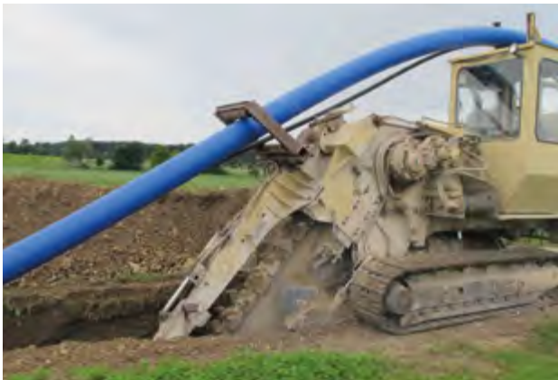
4. ábra: Keskeny árokásásos csőfektetés
