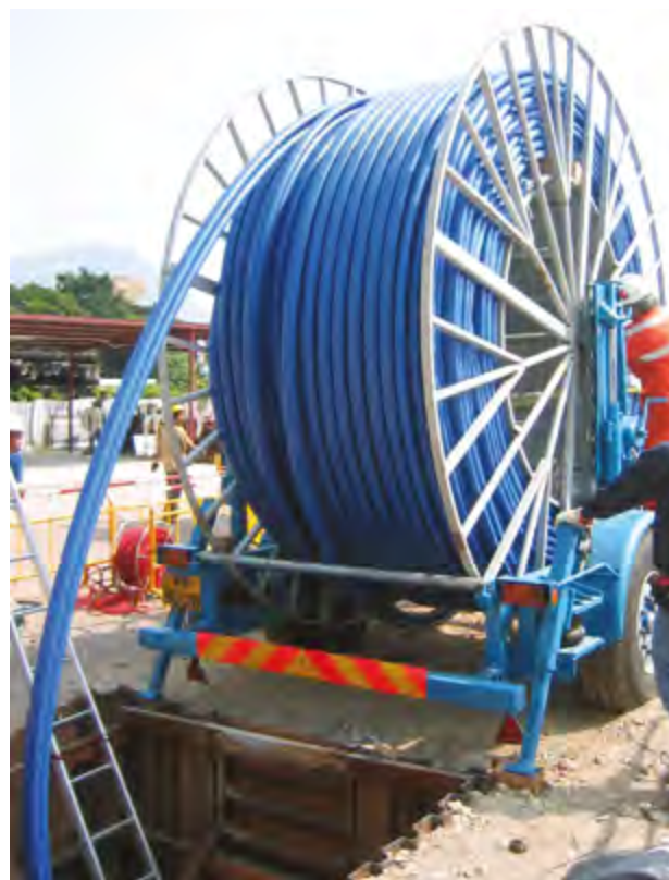
12. ábra: Gyárilag szűkített szorosan illeszkedő bélés (kompakt cső)
