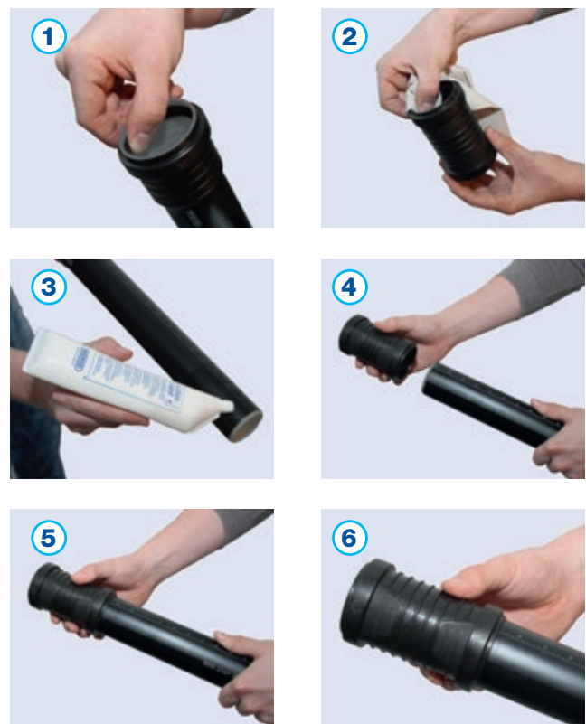
Abb. 48: Herstellen der Verbindung mit Aufsteckmuffe.
