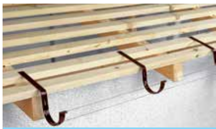
Montaż uchwytych stalowych prostych
