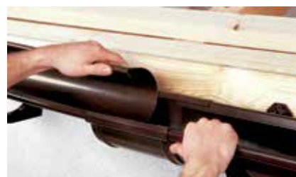
Montaż złączki rynny
