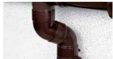
Montaż rury spustowej za pomocą dwóch kolan
