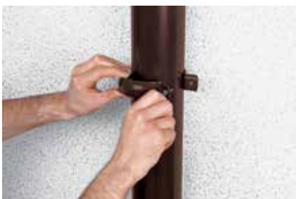
Montaż rur na ścianie drewnianej lub metalowej
