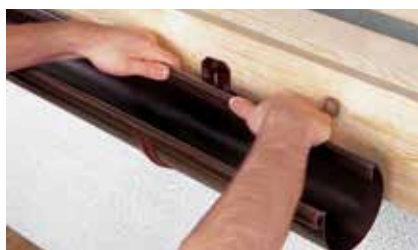
Montaż rynny w uchwytych stalowych
