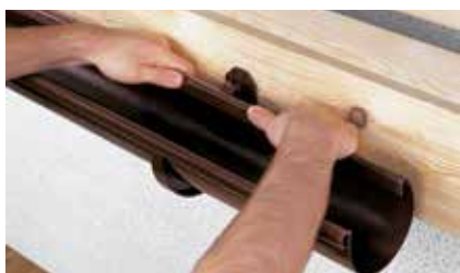
Montaż rynny w uchwytych tworzywowych
