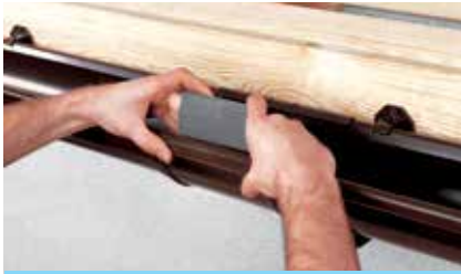
Montaż wkładki
