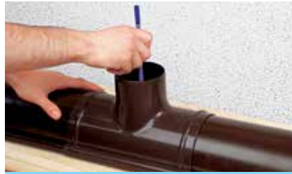
Montaż leja spustowego
