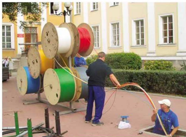
Фот. 2 Специальный пучок 8-ми микротруб Novomicro – 3 x 10, 2 x 7, 3 x 5, затягиваемый в волоконно-оптический трубопровод в г. Седльце.
