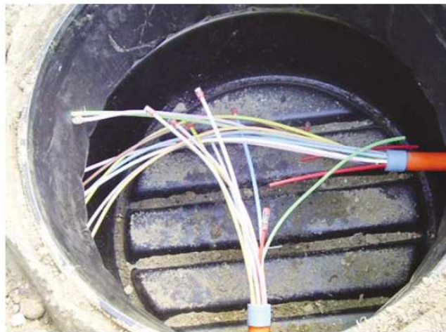
Фот. 8 Колодец KS 80.63/60, установленный в волоконно-оптической сети, реализованной для потребностей городского мониторинга в г. Радомск.
