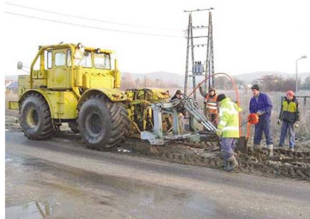
Фот. 7 Установка пучка Novonet DB 5/10 вдоль гминной дороги при помощи трактора с плугом-укладчиком
