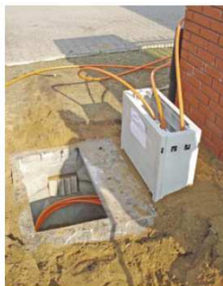
Фот. 13 Установленный цоколь распределительного шкафа
