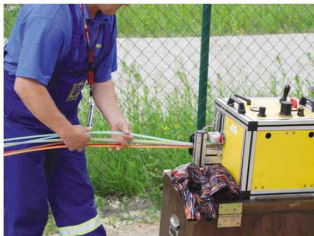
Фот. 5 Приспособление для вдувания микротруб Предприятия WPRT, вдувающее семь Novomicro 7 в трубопровод Opto 40 в г. Щецин.
