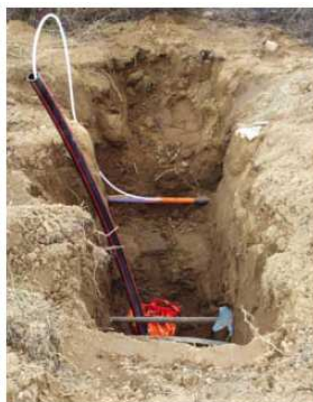
Фот. 12 Разветвление пучка Novosplit с пропускным каналом с PROTO 40
