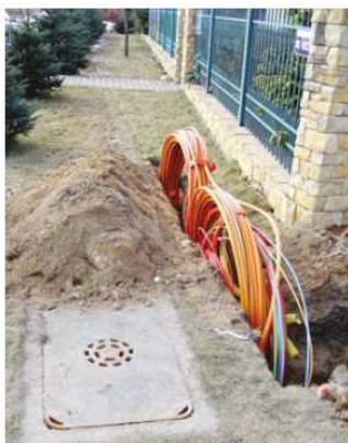
Фот. 11 Пучки Novosplit 7/8 в процессе проводки
