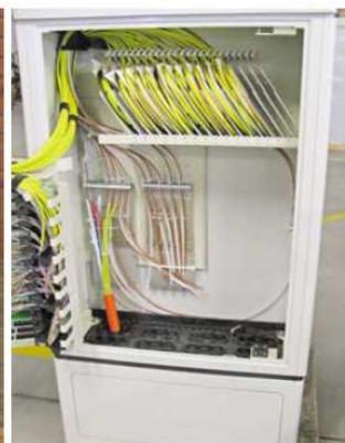
Фот. 14 Распределительный шкаф в процессе оснащения микротрубами, подводимыми к кассетам спаев
