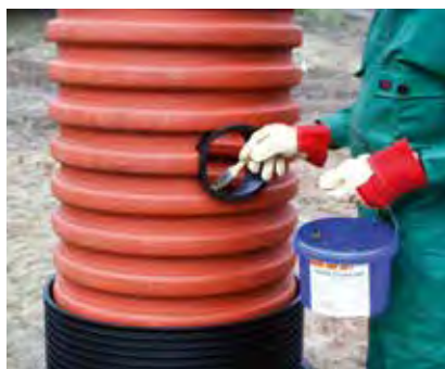
2. Następnie oczyszcza się krawędzie otworu z zadziorów.
