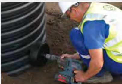
2. Następnie oczyszcza się krawędzie otworu z zadziorów.
