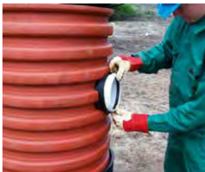
4. W przypadku trudności z montażem krawędzie otworu można posmarować środkiem poślizgowym.
