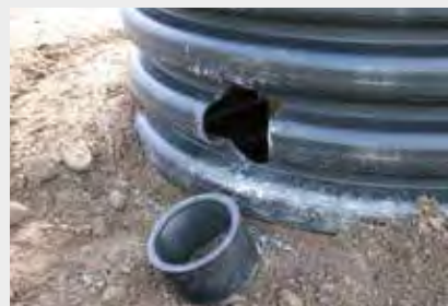
3. W wykonanym otworze montuje się uszczelkę wkładki in situ.
