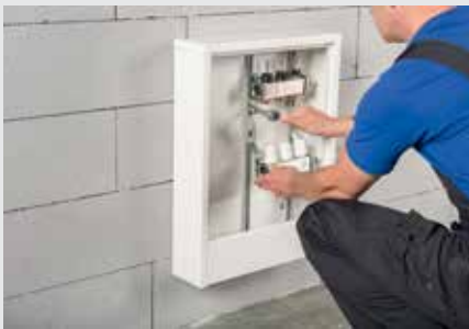
5. Montaż rozdzielacza w szafce rozdzielaczowej
