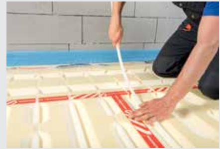
4.3. Montaż rur w izolacji
