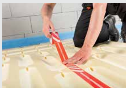
3.3. Układanie i klejenie paneli wciskowych
