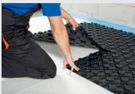
3.2. Układanie paneli wciskowych
