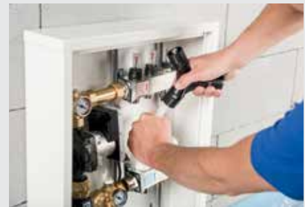
7. Kalibracja rury do rozdzielacza
