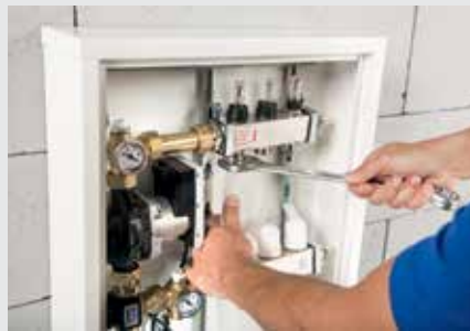
9. Przykręcenie rury do rozdzielacza
