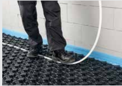
4.2. Montaż rur do izolacji
