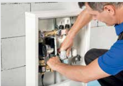
11. Montaż siłowników na belce powrotnej rozdzielacza
