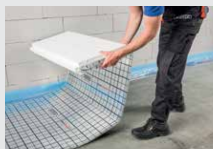
3.1. Układanie izolacji
