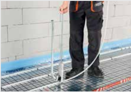
4.1. Mocowanie za pomocą tackera
