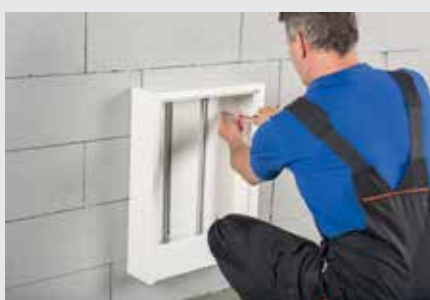
1. Lokalizacja i montaż szafki rozdzielczej
