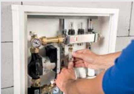
8. Podłączenie rury do rozdzielacza
