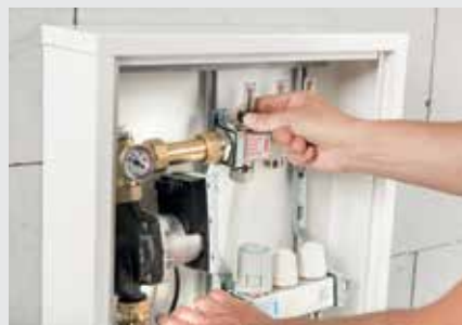
12. Regulacja przepływów na rotametrach
