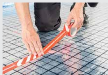
3.4. Klejenie płyt izolacyjnych
