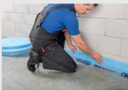
2. Montaż dylatacji przyściennej – taśma
