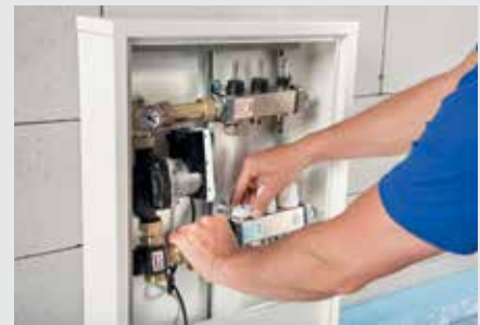
10. Montaż nakrętki na belce powrotnej rozdzielacza
