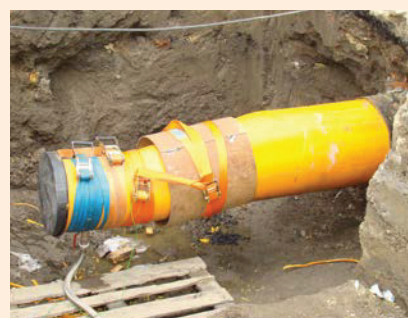
Sanace plynovodu DN 500 na ulici Nuselské v Praze proběhla za rušného provozu v těsné blízkosti tramvajového pásu
