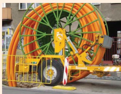
Sanace plynovodu DN 500 na ulici Nuselské v Praze proběhla za rušného provozu v těsné blízkosti tramvajového pásu
