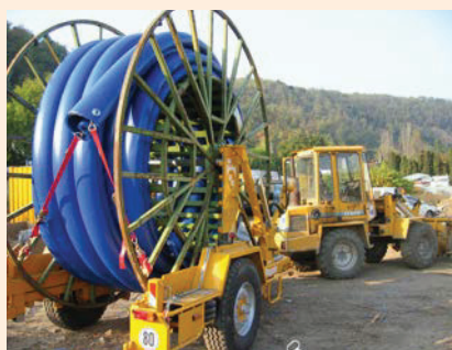
Sanace ocelového vodovodního přivaděče DN 400 v Praze – Chuchli vyřešila časté poruchy a zlepšila kvalitu pitné vody
