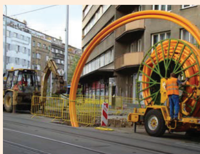
Sanace plynovodu DN 500 na ulici Nuselské v Praze proběhla za rušného provozu v těsné blízkosti tramvajového pásu
