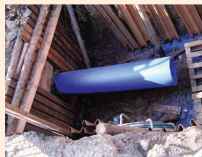
Sanace ocelového vodovodního přivaděče DN 400 v Praze – Chuchli vyřešila časté poruchy a zlepšila kvalitu pitné vody
