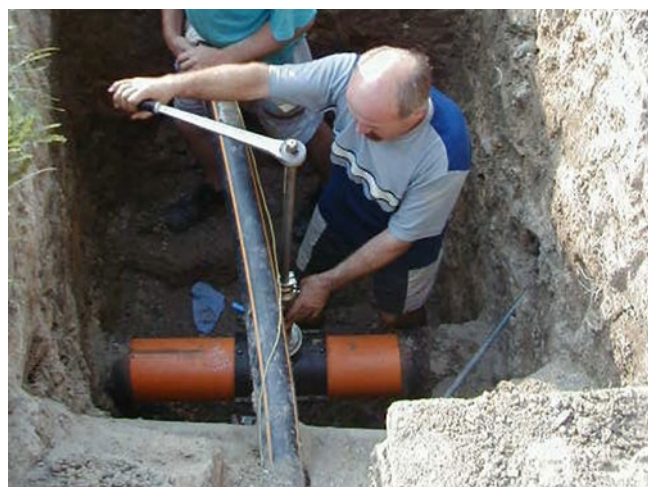
Vysazení přípojky pomocí sedlové tvarovky
