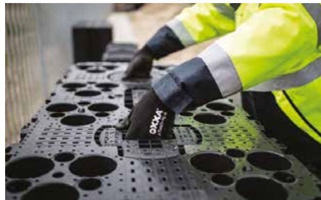
Rys. 15. Montaż zbiornika AquaCell - ergonomiczne uchwyty
