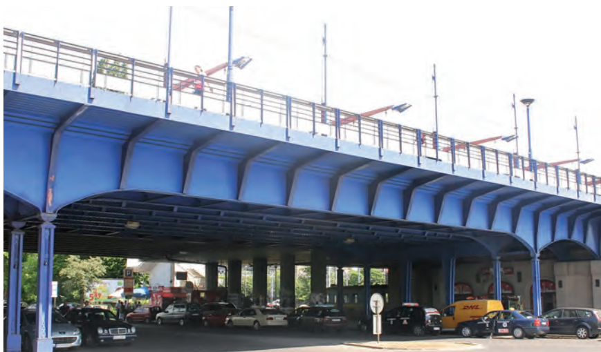
Trzy rurociągi SMR 160 zainstalowane na moście Dworcowym w Poznaniu.
