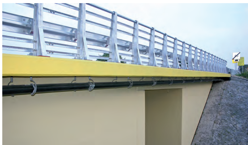
Dwa rurociągi SVA 110 zamontowane na remontowanym wiadukcie w miejscowości Chojna.
