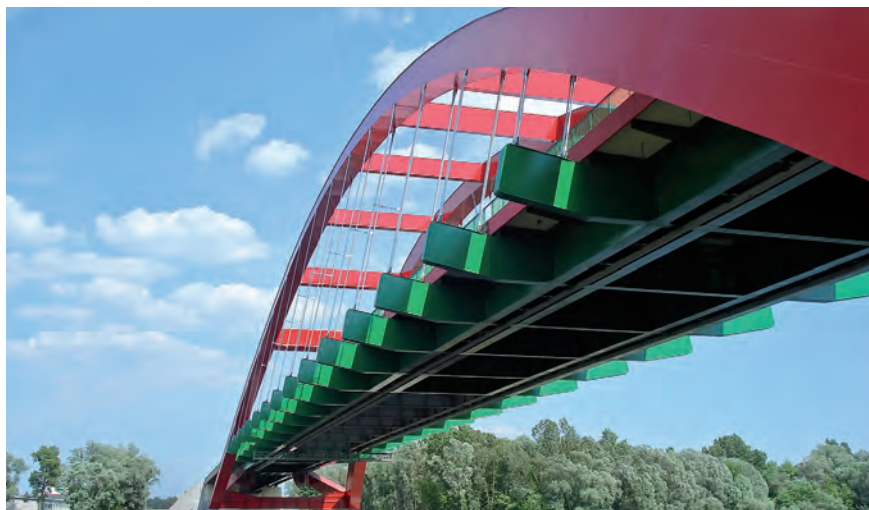
Podwójny rurociąg z rur SMR 160 i 110 zamontowany na moście w Puławach.
