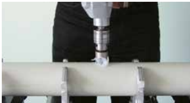
1/ Speciálním vrtákem (tab. vlevo) vyvrtáme otvor pro potrubí.
