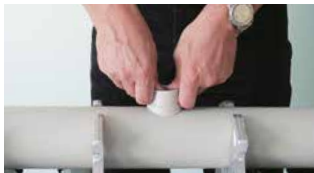
4/ Nahřáté sedlo nasuneme do nahřátého otvoru a fixujeme. Po uplynutí jedné hodiny lze napustit vodou a namáhat tlakem.
