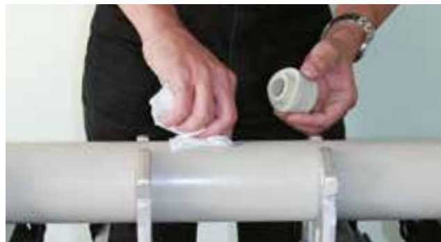
2/ Začistíme otvor a odmastíme tvarovku i vyvrtaný otvor.
