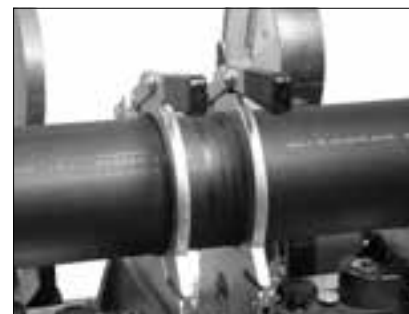
Správně připravené potrubí ke svařování
