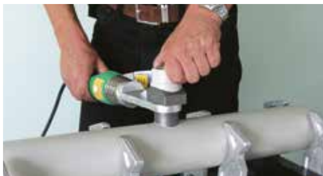
3/ Navařovací sedlo nasuneme na nástavec tak, aby na sebe navazovaly rýsky na sedle a nástavci. Prohřejeme otvor i navařovací sedlo. Doba prohřívání je v tabulce vpravo.
