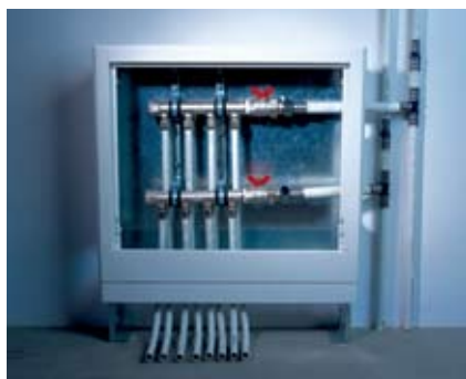
Подводка трубы к коллекторам
