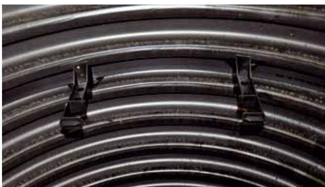
Рис. 6. Предварительный монтаж держателя лестницы в шахтной трубе.
