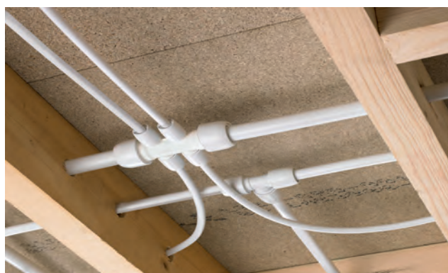
Rys. 26. System Hep 2 O skraca czas instalacji dzięki temu, że przewody rurowe można bez trudu przekładać przez otwory w belkach stropowych.
