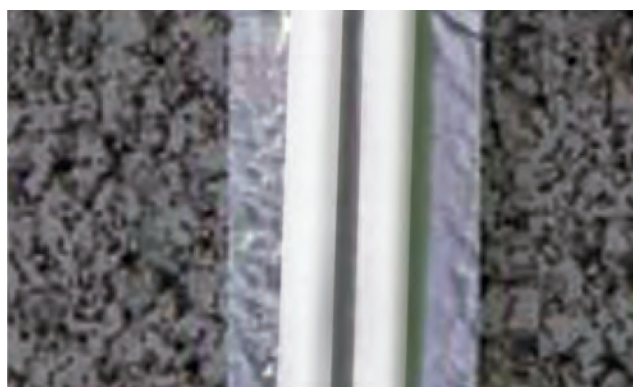
Rys. 32. Metalowej taśmy można używać w celu ułatwienia detekcji rury za pomocą przyrządów elektronicznych.
