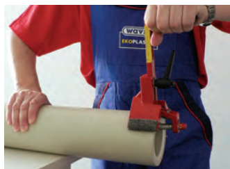
Ścięcie krawędzi (sfazowanie).
