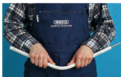
Gięcie za pomocą sprężyny.
