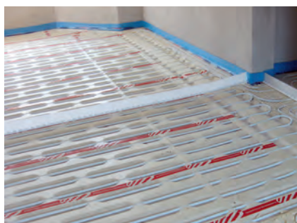
7. Montaż profili dylatacyjnych.
