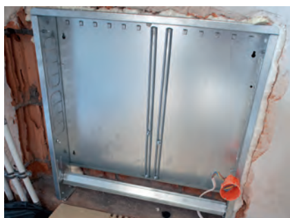
1. Montaż szafki rozdzielacza.
