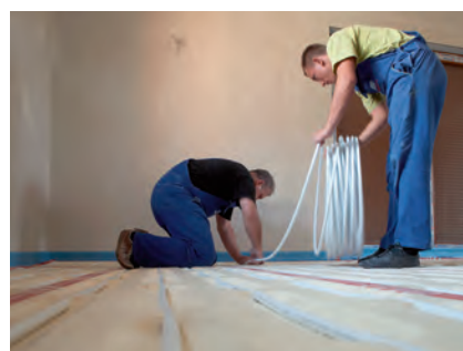
6. Montaż rury.
