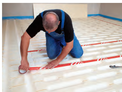
5. Uszczelnienie połączeń stykowych taśmą izolacyjną.
