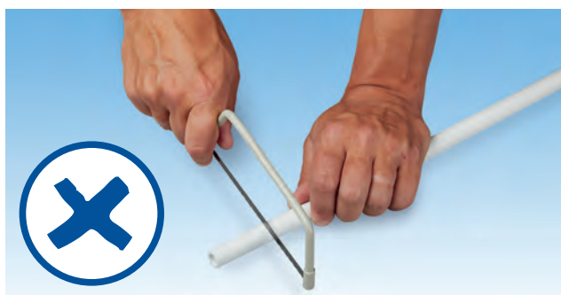
Rys. 7. Do cięcia rur Hep 2 O nie wolno używać piły do metalu czy drewna.
