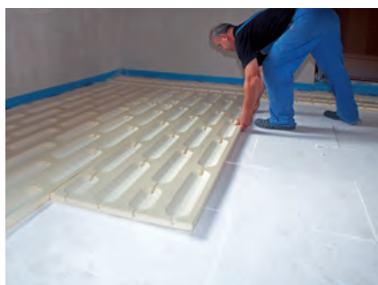
4. Rozłożenie paneli zgodnie z załączonym schematem.
