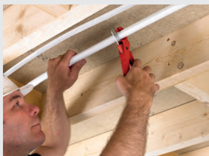
Pomiar i przycinanie w miejscu instalacji.
