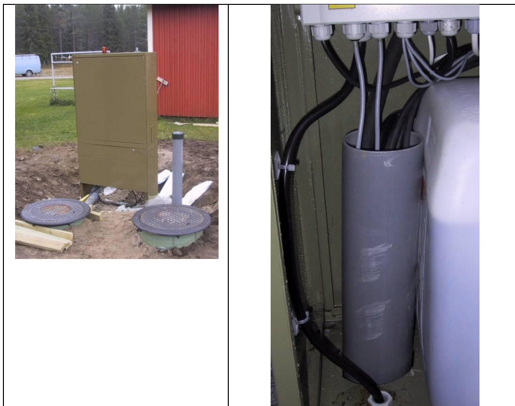
Kuva 15. Laitesuojan asennus ja kaapeleiden läpivienti.
