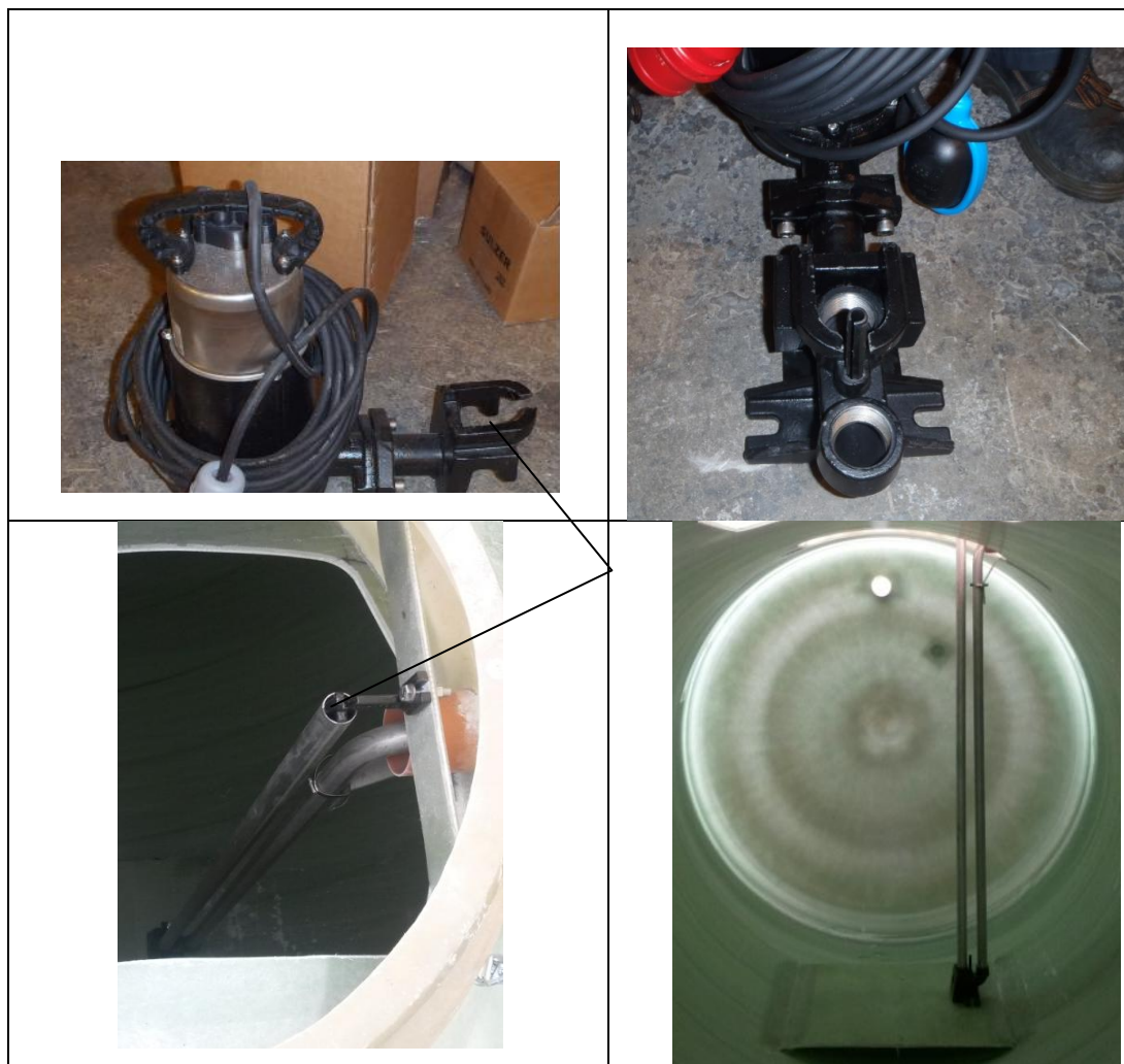
Kuva 18. Repijäpumpun asennus.
