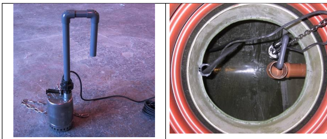
Kuva 16. Poistopumpun asennus.
