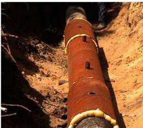
14 pav. Prijungimo prie sąveikaujančio Compact Pipe vamzdžio pavyzdys.
