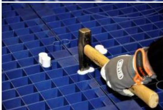
Teisingas horizontalių jungčių (kabių) montavimas
