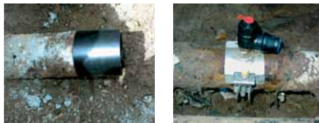
Рис. 35. Концевой фитинг и патрубок для подключения
