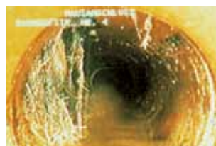
Рис. 5. Повреждение канализационной трубы корнями
