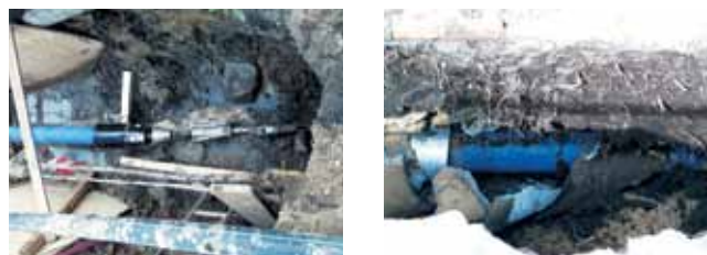
Рис. 42. Wavin TS также для метода замены с разрушением старых труб
