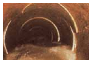
Рис. 4. Структурные повреждения и отложения в канализационной трубе
