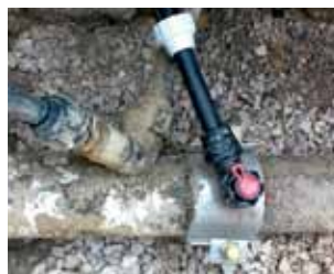
Рис. 39. Подключение отвода с использованием компактного патрубка
