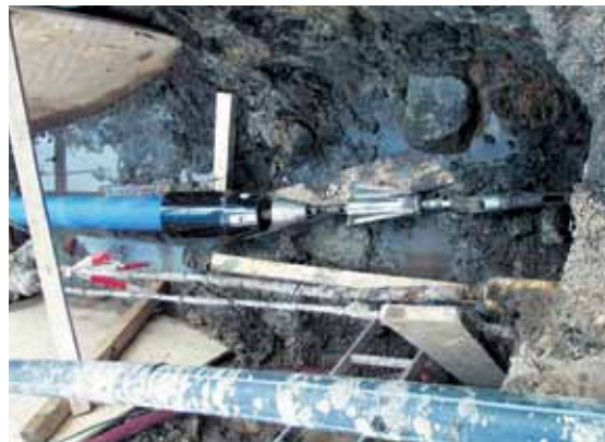
Рис. 15. Разрушение трубы
