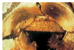
Рис. 6. Сильно поврежденная канализационная труба
