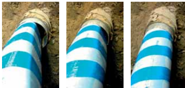
Рис. 37. Compact SlimLiner расширена с использованием «холодного» процесса
