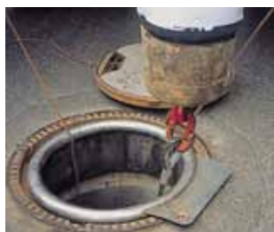
Рис. 29. Для восстановления канализации могут использоваться существующие колодцы
