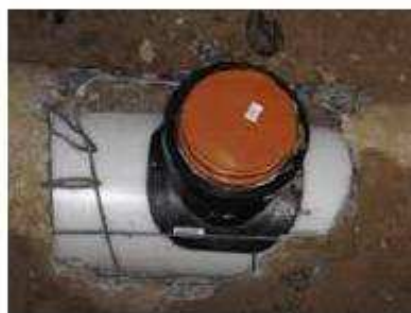
27 a, b pav. Atšakos prijungimas panaudojant iš viršaus prilydomą elektrinio lydymo balną.
