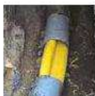
17 pav. Compact Pipe sistemos principas.
