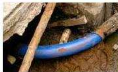
19 pav. Aptaisto vamzdžio tiesimas posūkiuose.
