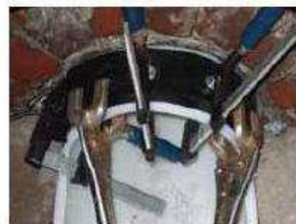
25 a, b, c pav. Fiksavimo antdeklų pritvirtinimas prie išsikišančio Compact Pipe galo šulinyje.
