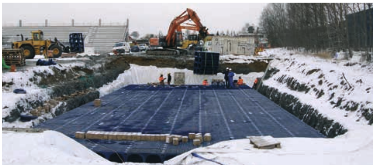
1060 stycken Wavin Q-Bic™ dagvattenkassetter i två lager. Det ger en volymkapacitet på 450 m 3 . Det tog endast en dag för fem personer att installera hela anläggningen.
