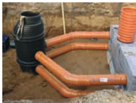
Med hjälp av Wavins brunnsprogram är det möjligt med flexibla placeringar av in- och utlopp samt inspektions- och rensningsmöjligheter.
