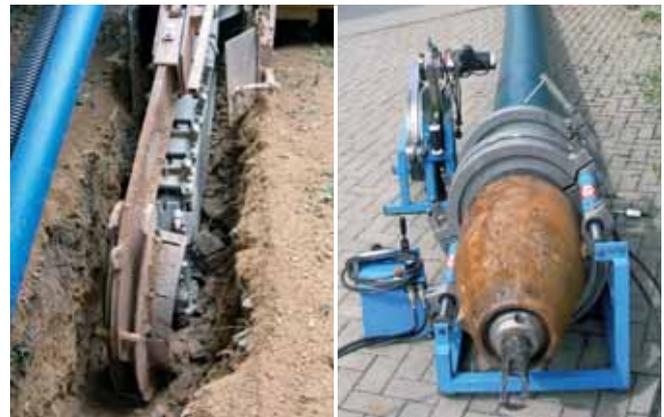
Abb. 16/17: Alternative, sandbettfreie Verlegungen von Wavin SafeTech RC<sup>n</sup>
