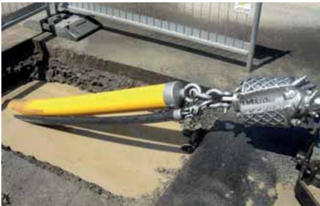
Abb. 15: Alternative, sandbettfreie Verlegungen von Wavin SafeTech RC<sup>n</sup> – Horizontalspülbohrung
