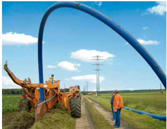
Abb. 10: Alternative, sandbettfreie Verlegung von Wavin SafeTech RC® durch Pflugverfahren
