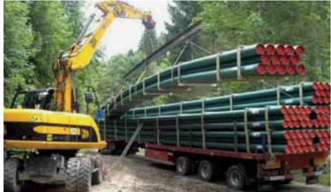
Abb. 1: Stangenware in 20-m-Längen
