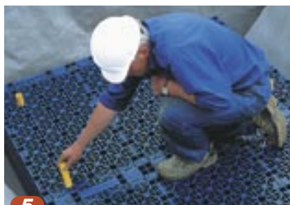
5 Monter stabelpinde, hvis magasinet består af flere lag (min. 2 stk. pr. kassette), for at fastholde kassetterne.
