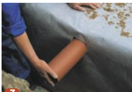
7 Pak magasinet ind i geotekstilet. Monter regnvandsrøret og evt. udluftningsrøret i tilslutningen.
