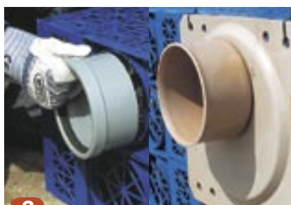
2 Monter pladen eller tilslutningsmuffen på kassetten.
