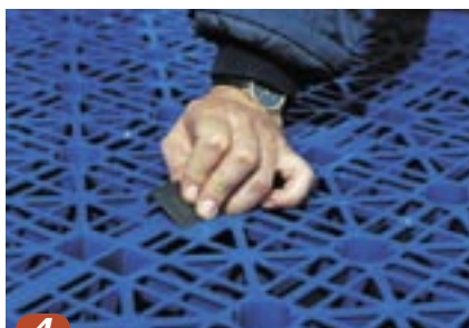
4 Anvend clippen til at holde kassetterne sammen. Kassetterne i øverste lag fastholdes vandret med 2 clips pr. kassette.
