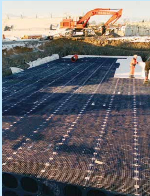
1.060 Wavin Q-Bic regnvandskassetter i to lag. Det giver et magasin med en kapacitet på 450 m 3 .
