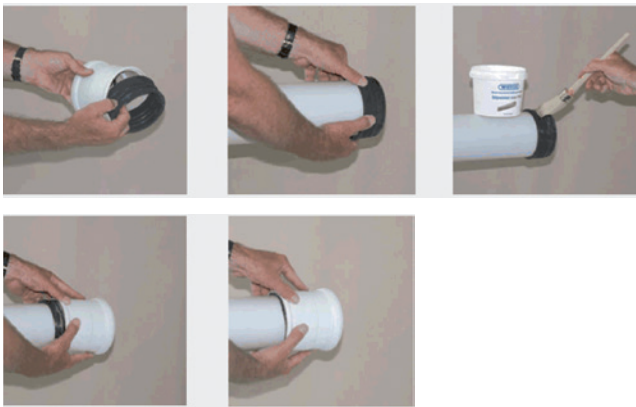
Afb. 5.3 Montage van de expansiezijde van de steekmof.
