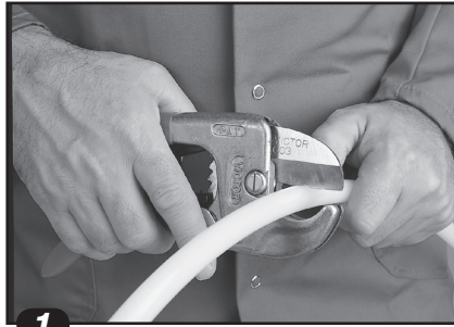
1 Pex-røret afkortes vinkelret. Det gøres nemt med en rørsaks.
