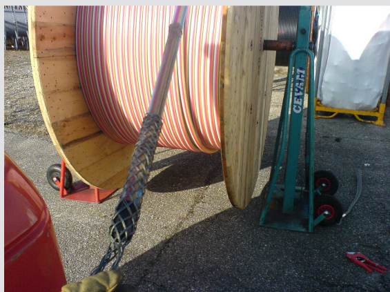
Korrekt sammenkobling af rør
