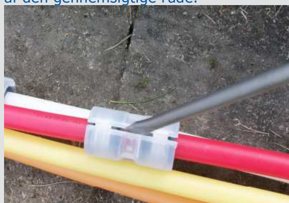
6. Kontroller forseglingskvaliteten, før den genbruges.
