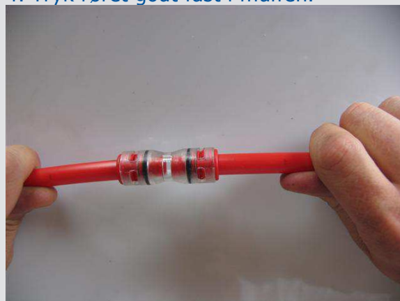
6. Kontroller, at røret er installeret korrekt, ved at trække i det.
