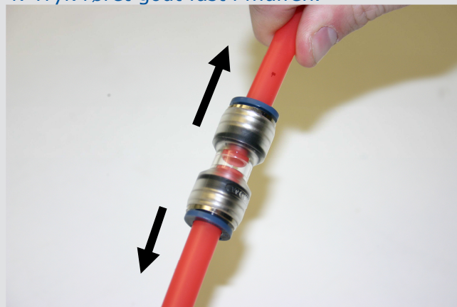
6. Kontroller, at røret er installeret korrekt, ved at trække i det.
